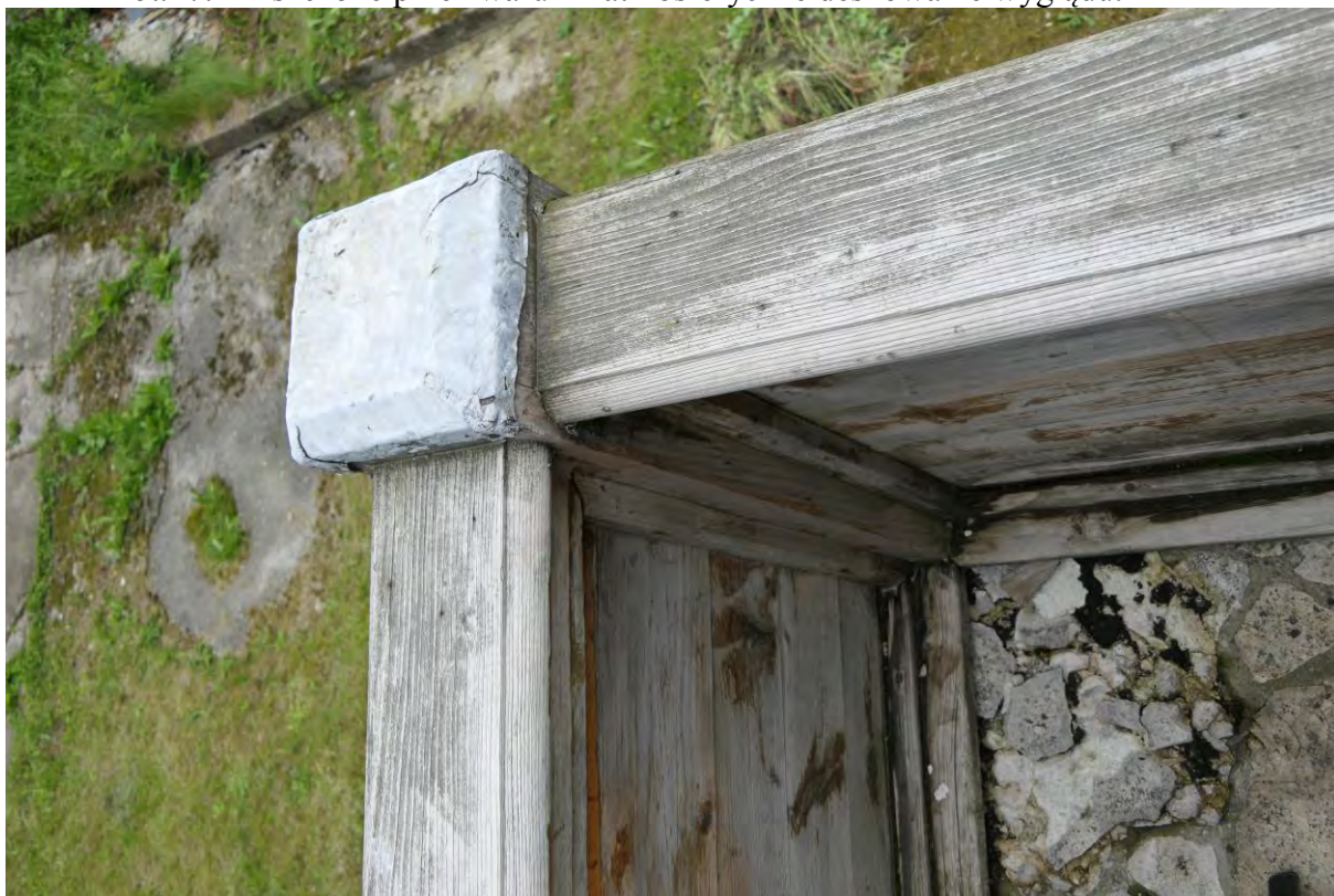
Fot.18. Zabezpieczony niefachowo blachą słupek balustrady tarasu. Widoczne uszkodzenie kamiennej okładziny tarasu.
