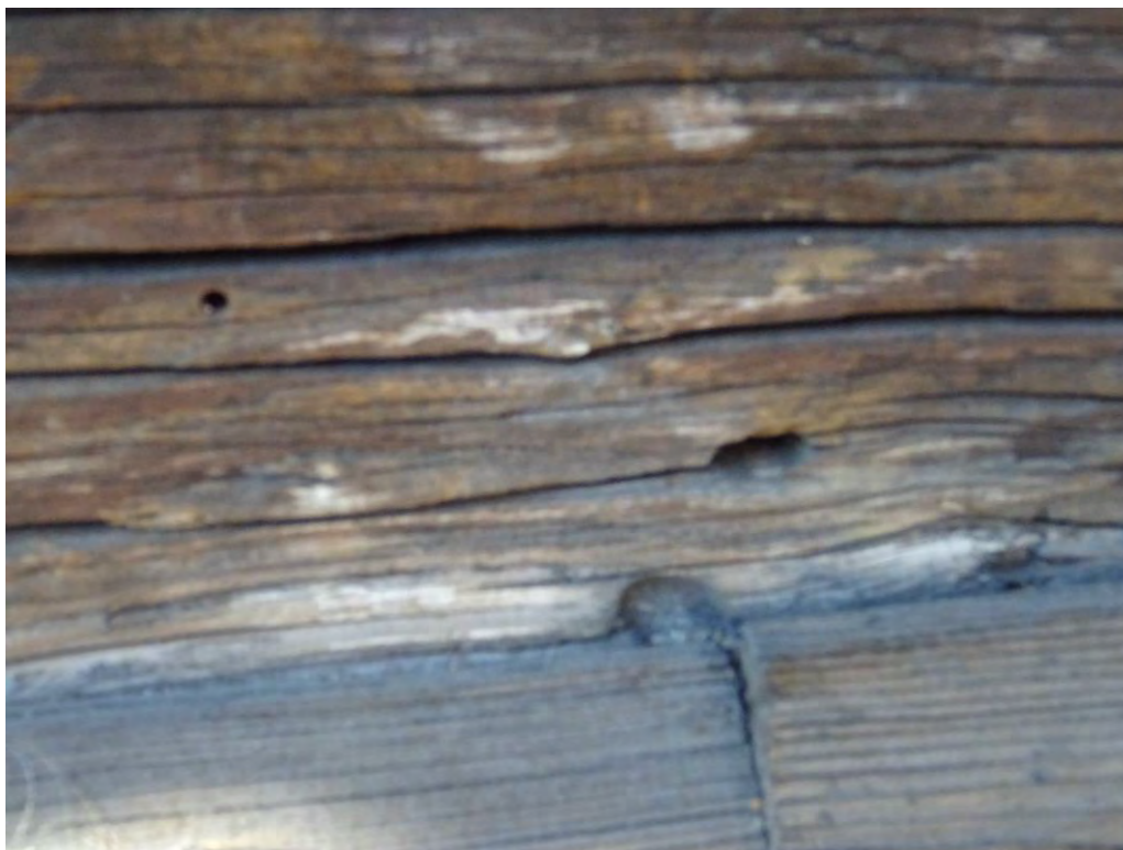
Fot.5. Belka w ścianie frontowej (pierwsza nad chodnikiem) – porażona przez spuszcza pospolitego.
