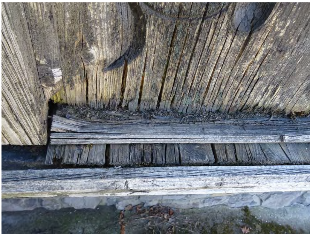
Fot.9. Zniszczone przez grzyby domowe deskowanie chodników i balustrad drewnianych.
