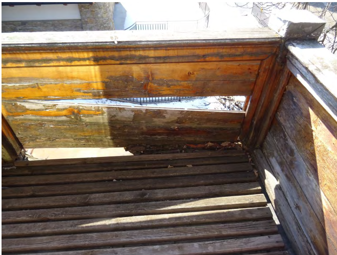
Fot.11. Zniszczona przez grzyby domowe drewniana balustrada balkonu.
