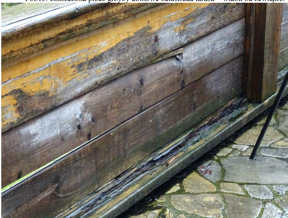
Fot.16. Zniszczona przez grzyby domowe balustrada tarasu – widok od wewnątrz.
