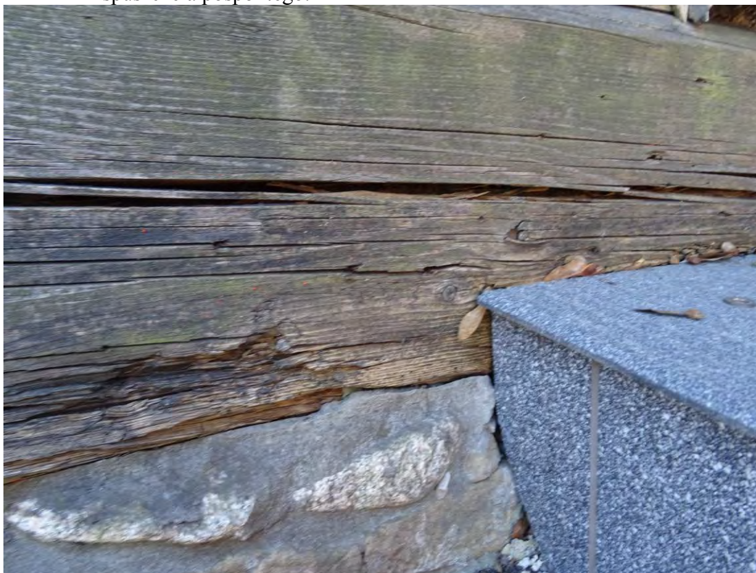
Fot.6. Podwalina werandy porażona przez grzyby domowe i spuszcza.
