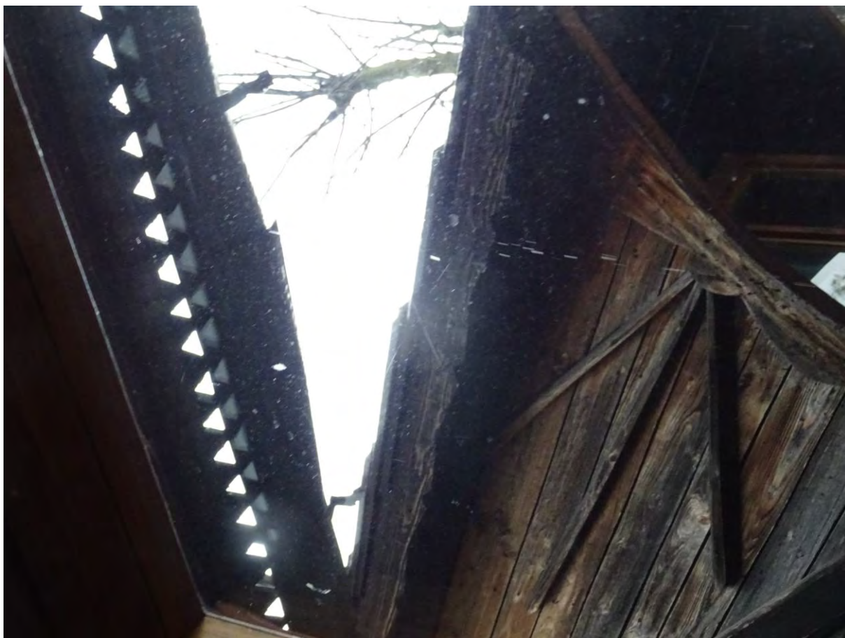
Fot.17. Zniszczone przez warunki atmosferyczne deskowanie wyglądu.
