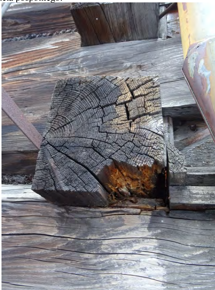
Fot.4. Część starsza. Ściana frontowa. Widoczna pierwsza belka przy chodniku drewnianym porażona przez grzyby domowe. Widoczne ubytki drewna.
