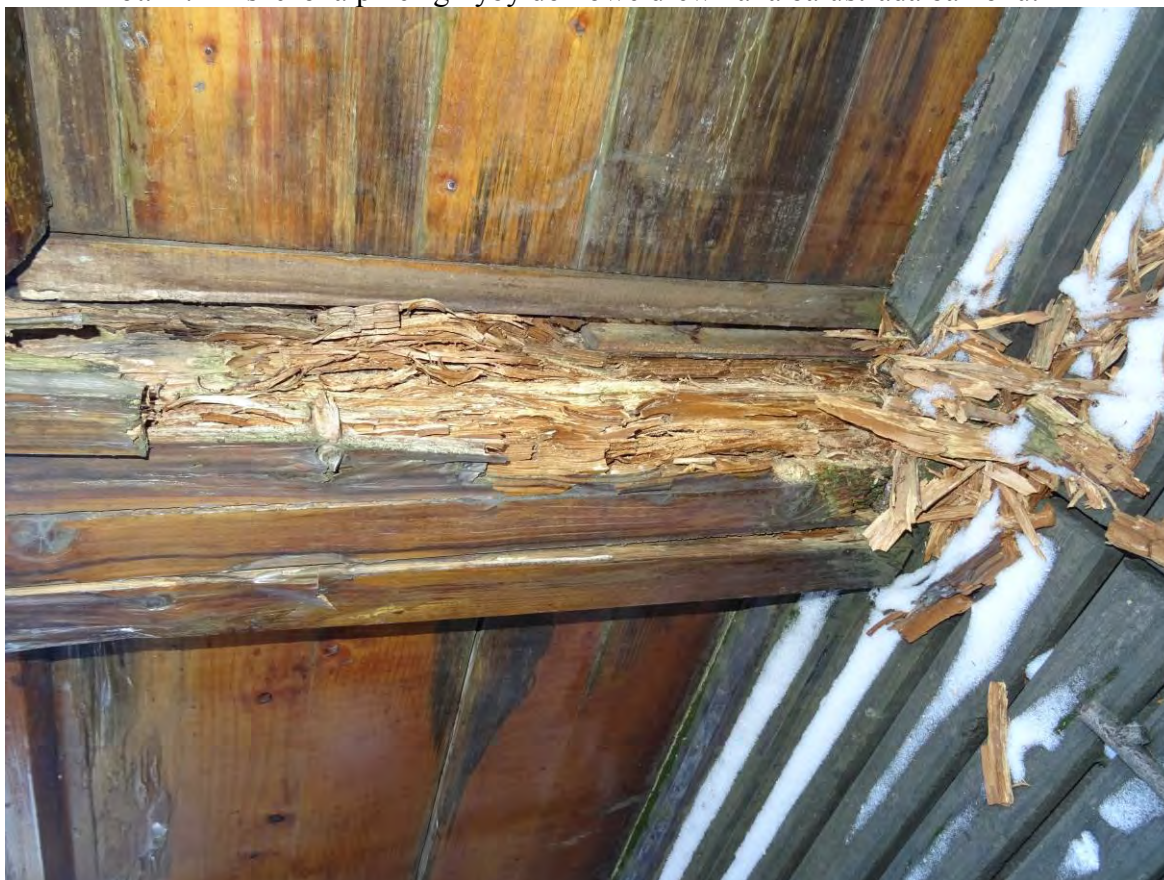
Fot.12. Całkowicie zniszczony przez grzyby domowe słupek drewniany balustrady balkonu.
