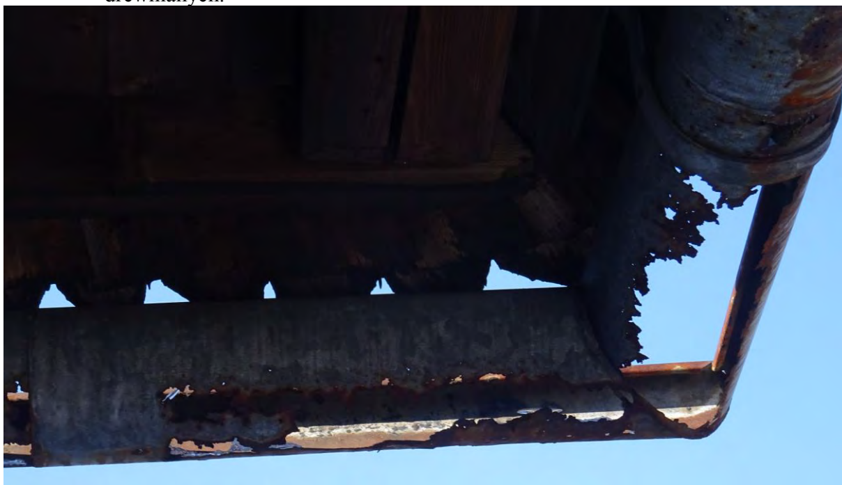
Fot.10. Zniszczone przez korozję rynny dachowe.
