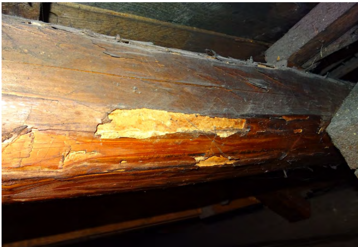
Fot.1. Część starsza. Więźba dachowa. Widoczna oryginalna krokiew porażona powierzchniowo przez spuszczela pospolitego.
