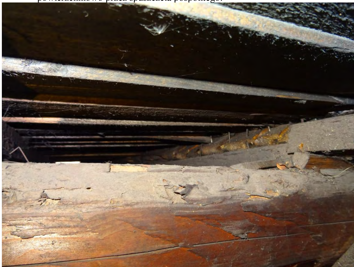
Fot.2. Część starsza. Więźba dachowa. Płatew oryginalna, porażona powierzchniowo przez spuszczela pospolitego.
