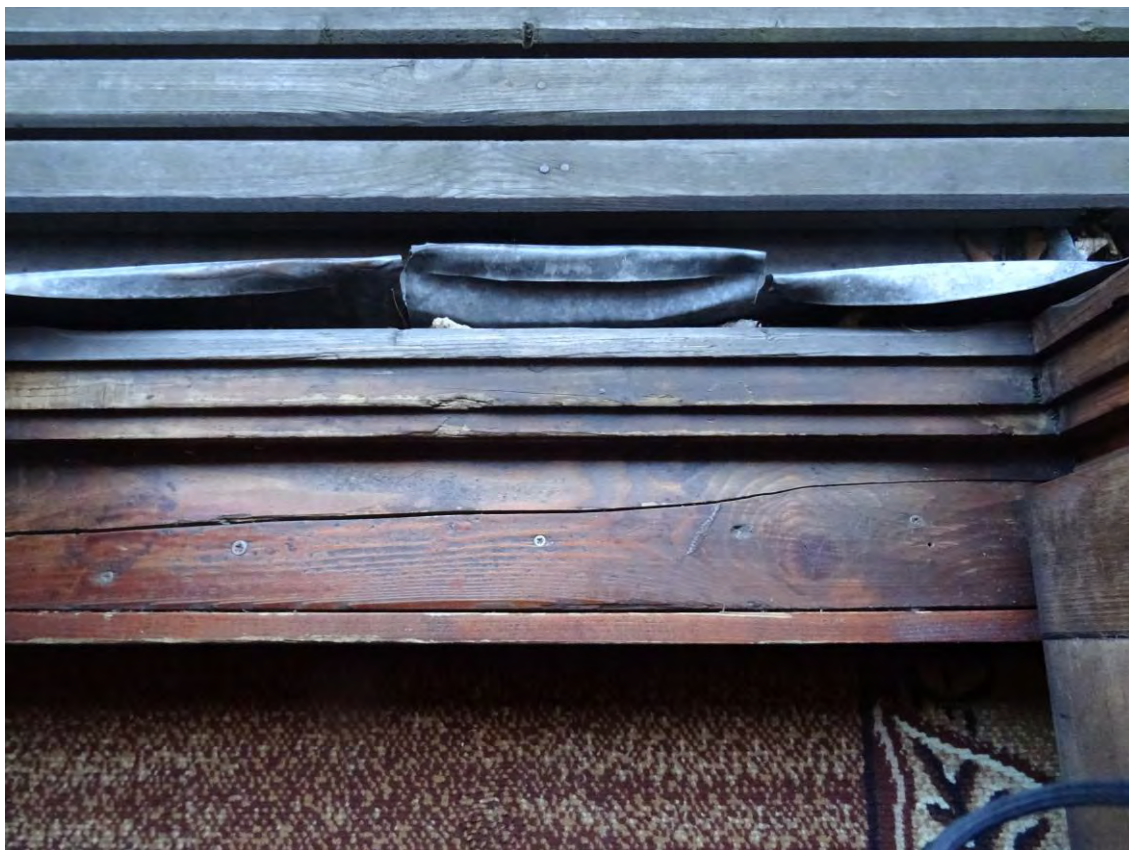
Fot.13. Zniszczone obróbki blacharskie balkonu (przy drzwiach balkonowych).
