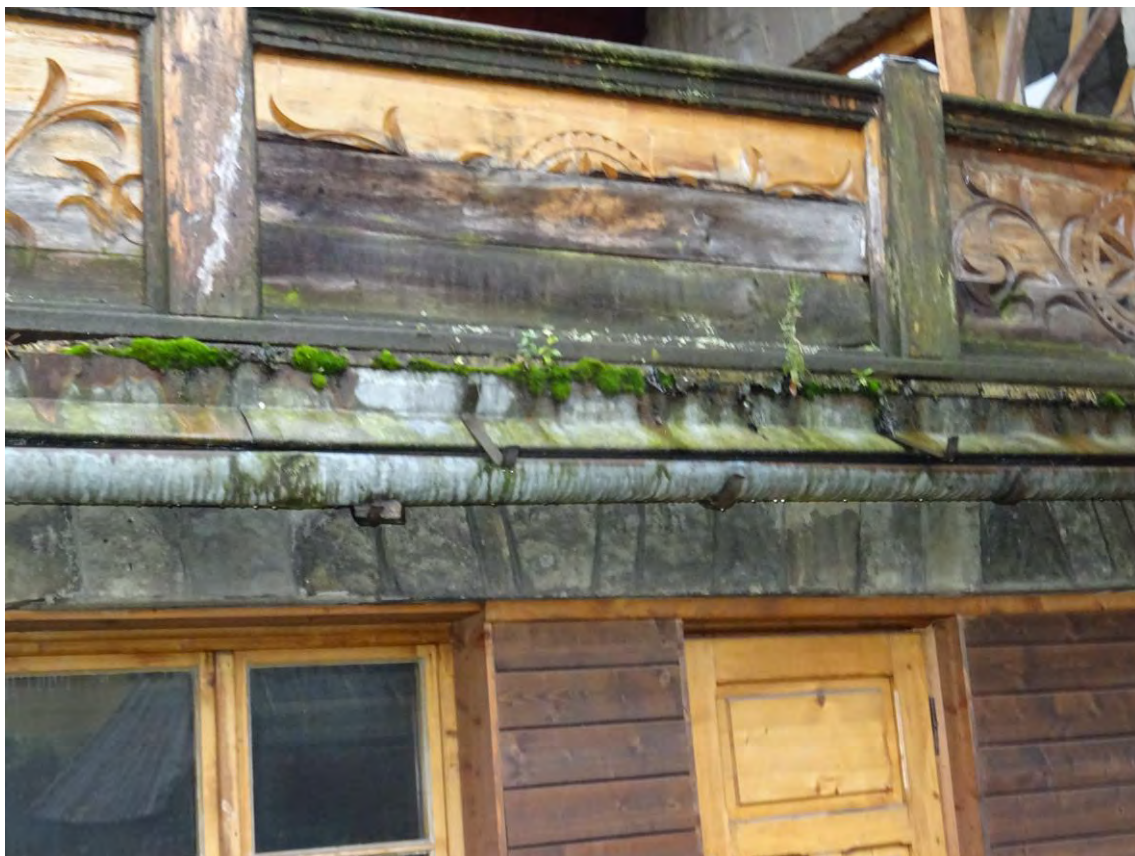
Fot.15. Zniszczona przez grzyby domowe balustrada tarasu – widok od zewnątrz.
