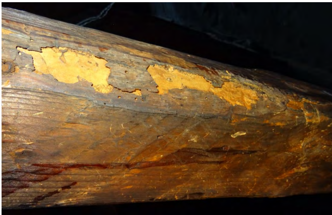
Fot.3. Część starsza. Słup więźby dachowej porażony powierzchniowo przez spuszczela pospolitego.
